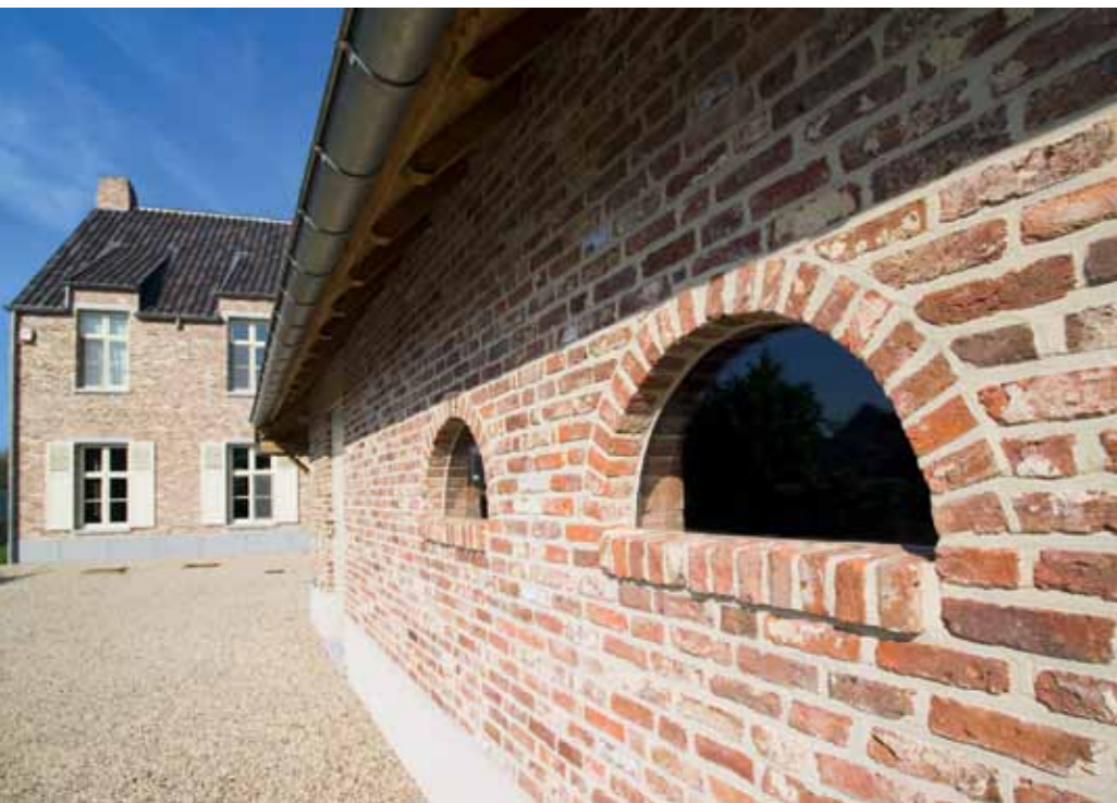
Foto links: het glas van de ramen van de garage werd rechtstreeks op de stenen verlijmd. “Qua isolatie niet de beste optie,” geeft Bart toe, “maar het oogt wel zeer mooi. Aangezien de garage geen voltijdse leefruimte is, is het energieaspect hier minder van belang en vond ik het wel kunnen om het esthetische aspect volledige voorrang te geven.”
